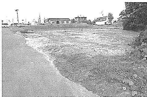
道路の高さまで盛土
