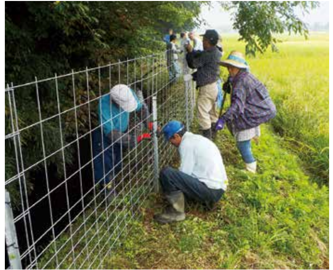
設置作業の様子
