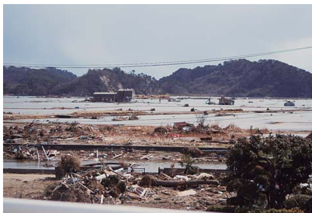
⑩ 東松島市東名 防潮堤が破壊され冠水した水田
